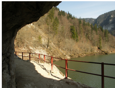
6. 7. En aval du saut
