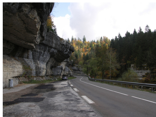
7. Une entrée de site à requalifier.
